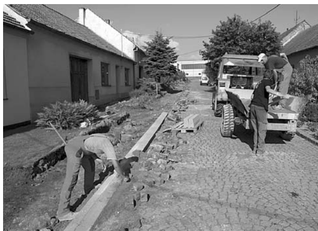
Oprava chodníku v horní části ulice Střední.
