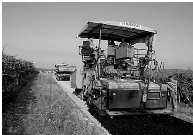
Pokládání asfaltového koberce na novém úseku stezky pro cyklisty i pěší turisty.
