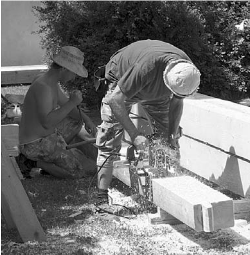
Příprava nových krovů na střechu kostela, provázená vůní dřeva ...
