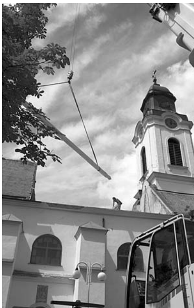
Technicky náročná manipulace s krovu si vyžádala pomoc těžké techniky a přesné práce její obsluhy.
